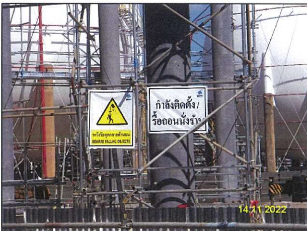
ง) การกั้นพื้นที่ด้านล่างและการติดตั้งป้ายเตือนการปฏิบัติงานบนที่สูง
