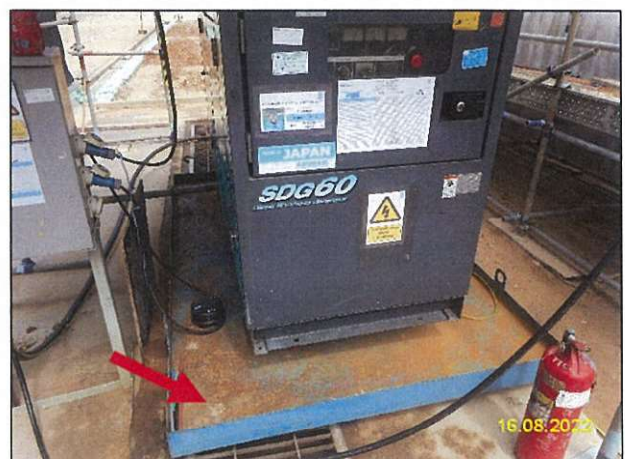
รูปที่ 2-9 การจัดเตรียมอุปกรณ์ป้องกันการรั่วไหลของน้ำมัน
