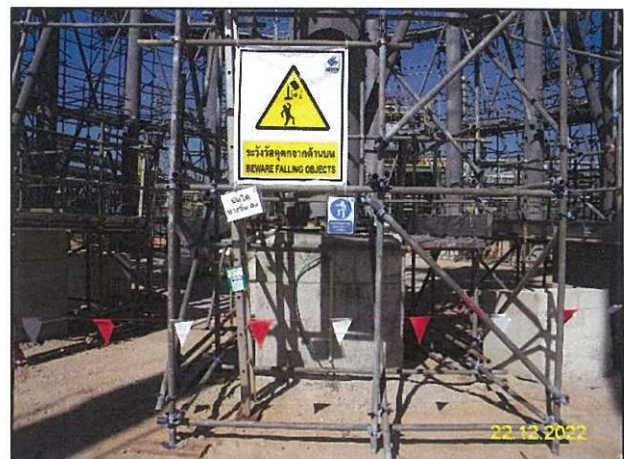
ง) การกั้นพื้นที่ด้านล่างและการติดตั้งป้ายเตือนการปฏิบัติงานบนที่สูง
