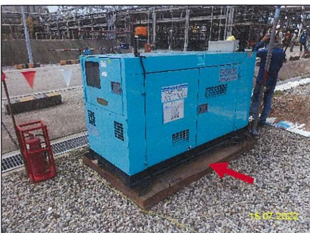
รูปที่ 2-9 การจัดเตรียมอุปกรณ์ป้องกันการรั่วไหลของน้ำมัน
